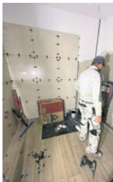
Prace w sali wiejskiej w Kandlewie.
