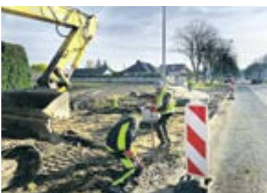
Budowa ścieżki w Hetmanicach.
