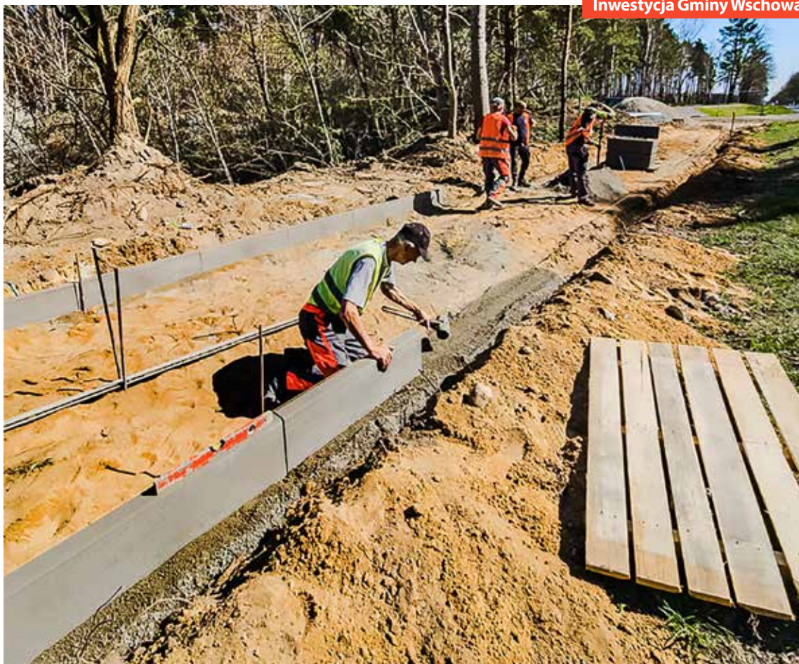
Budowa ścieżki w pobliżu zwirowni
