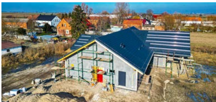
Budowa sali wiejskiej w Kandlewie – tak obecnie wygląda budynek
