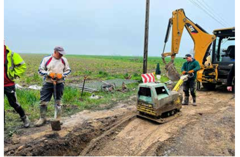
Ważnym zadaniem jest postępująca budowa kanalizacji do Konradowa.
