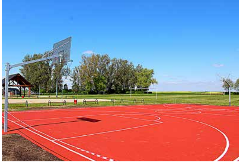
Jedną ze zrealizowanych w tej kadencji inwestycji jest budowa nowego boiska w Przyczynie Górnej.
