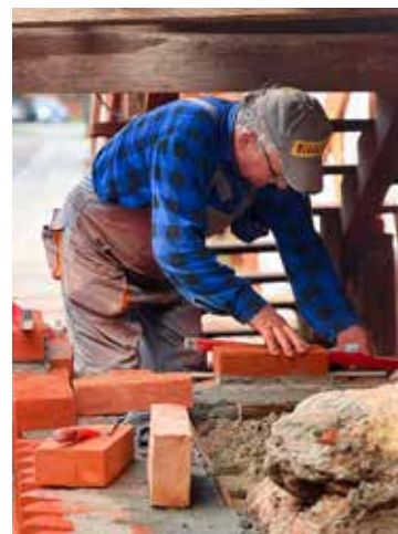
Misterna praca przy odbudowie schodów przy ul. Rzeźnickiej
