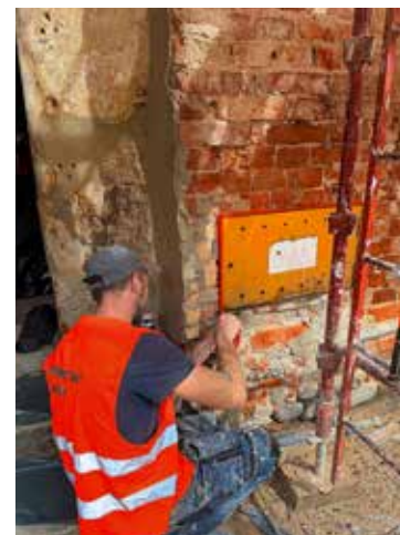
Na ks. Kostki – prace przy elewacji kamienicy
